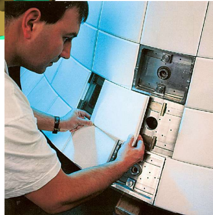
Abb. 114: Befestigung der Liner
